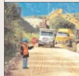
Le développement de l'infrastructure physique constitue un complément important pour l'intégration économique.
